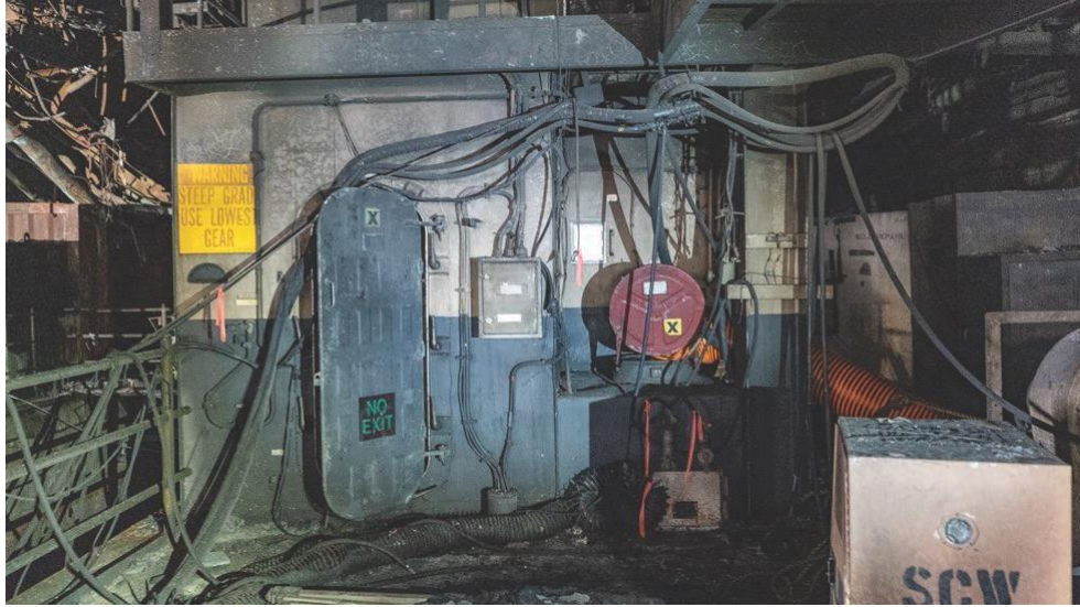
Resim – 3 Alt V güverteye hizmet veren 15 ve 16 sprinkler grupları için AFFF basmalı butonlarının fotoğrafı (solda 16; sağda 15). Bu basmalı butonlar, gemi ortasında Üst V' güvertededir. Açık bir kaporta, basma düğmelerinin görünürlüğünü engellemektedir. 78
